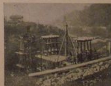
A Podmeletzi hid építése
