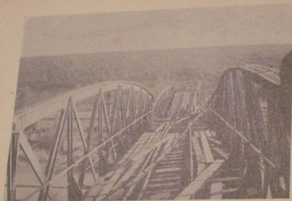
A San felrobbentott hídjá.
